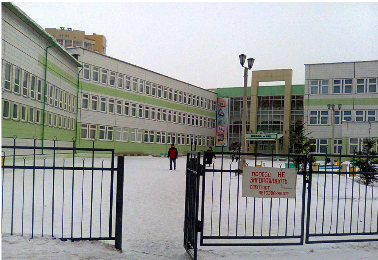
Территория, прилегающая к зданию Фото 1
